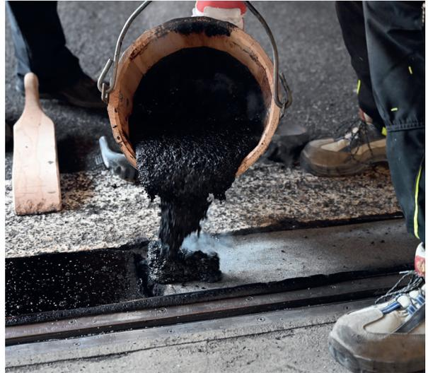
Abb. 2: Gussasphalteinbau von Hand
