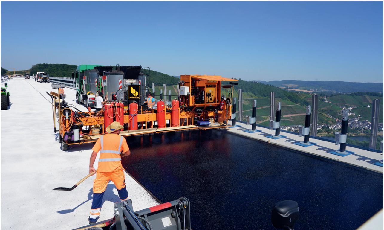
Abb. 3: Gussasphalteinbau mit einer Einbaubohle
