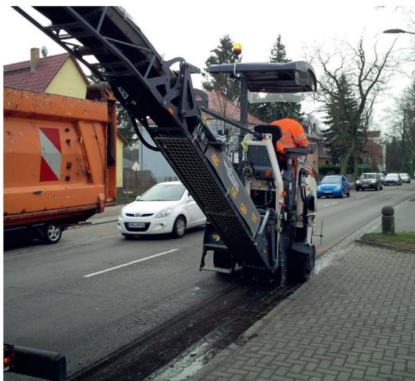
Abb. 4: Ausbau eines Asphalttes mit Straßenfräse
